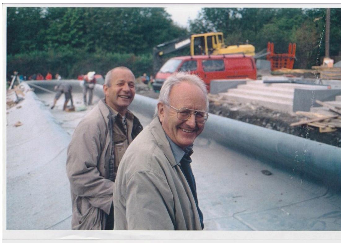
Fig 16: Bård Breivik (bak) og arkitekt/prosjektleder/pådriver Jørn Skaare under monteringen av bassenget på Klosterenga, september/oktober 1999. Foto: Privat
