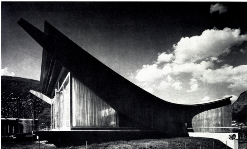
III. 5.7 og 5.8: Portalbygningen på Nesflaten og i Rødal. Eksteriørfotografier. Foto: Bjørn Winsnes. Hentet fra Byggekunst vol. 52, nr. 5, 1970.
