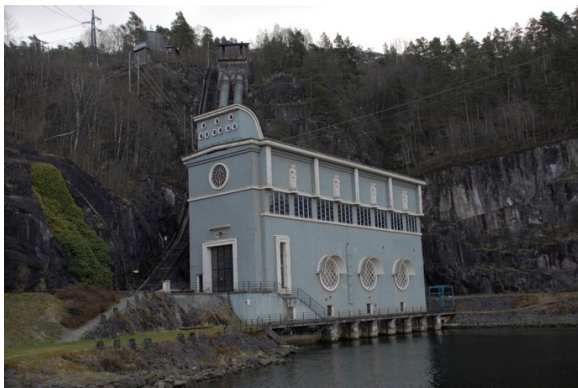
III 2.1: Bjerke og Eliassen. Sauda III kraftstasjon. Innviet 1930. Foto: Ulf Ingemar Gustafsson, Riksantikvaren. U.å. 12.09.2021. Hentet fra: https://www.riksantikvaren.no/fredninger/sauda-iii-kraftverk/
