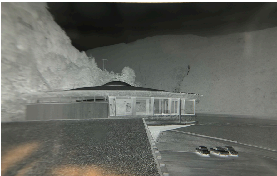
III. 5.15: Kontrollrommet på Nesflaten. Foto: Geir Grung. Negativ. Privat fotoarkiv.
