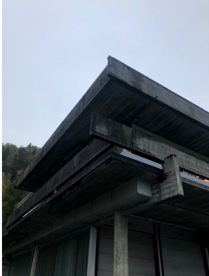
III. 3.10: Kontroll- portal og verkstedsbygningen på Nesflaten. Detalj. Foto: Eget. 19.10.2021.
