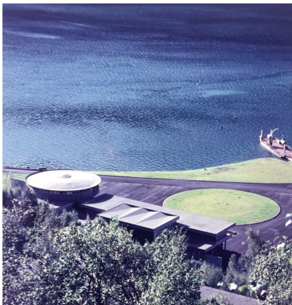
III. 5.19: Kontrollbygningen og beplating på Nesflaten. Tatt fra funksjonærmessen. Foto: Ant. Geir Grung. Privat fotoarkiv.
