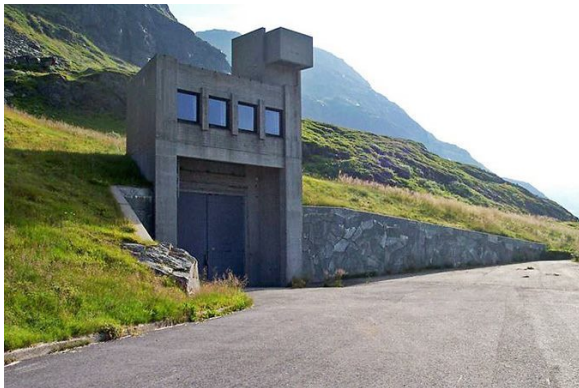
III. 4.2: Svandalsflona kraftverk, portalbygning. 1977. Foto: Lyse konsern. Hentet fra: https://www.lysekonsern.no/virksomhet/energi/vannkraft/svandalsflona-kraftverk
