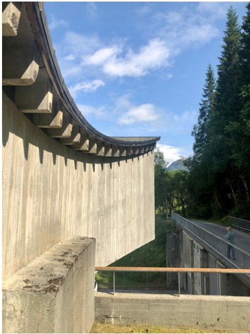
III. 4.1: Portalbygningen i Røldal. Bjelkelag i møte mellom vegg og tak. Foto: eget. 17.07.2021.
