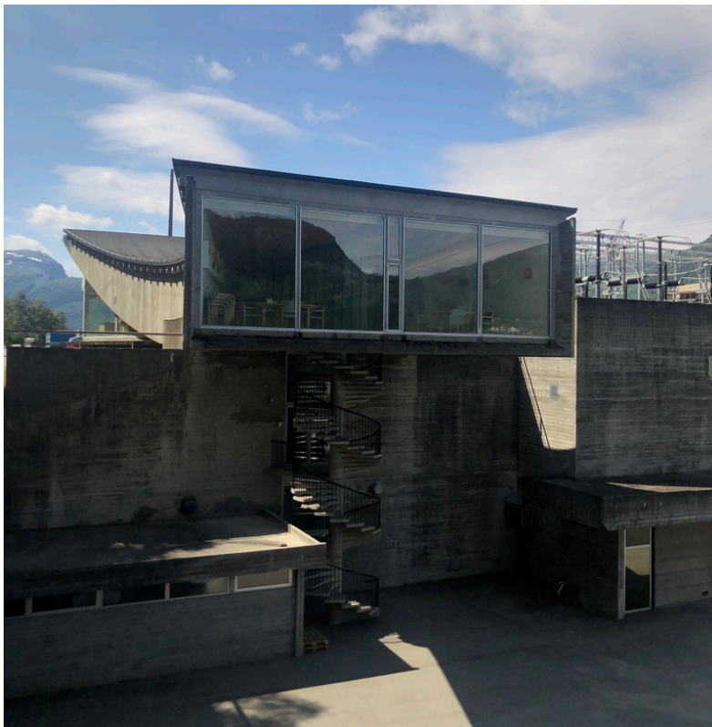
III. I.2: Portalbygning i Røldal. Fasade mot nord. Foto: eget. 17.07.2021.
