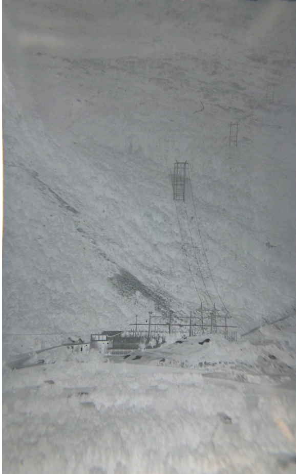
III. 5.11: Portalbygning, koblingsanlegg og strømmaster i Røldal. Negativ. Foto: Geir Grung. Privat fotoarkiv.
