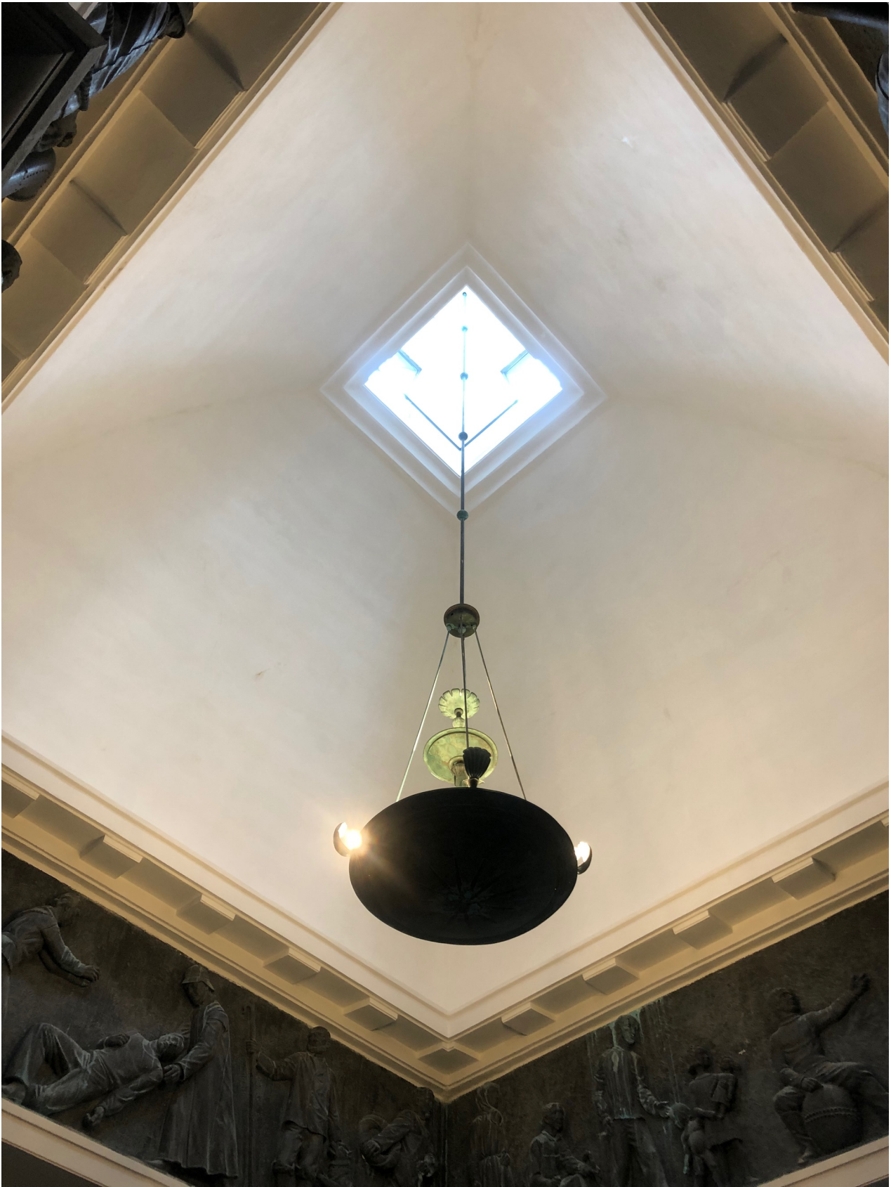
Figur 38: Kuppel, lysinnfall og lampe. Hall. Eget foto
