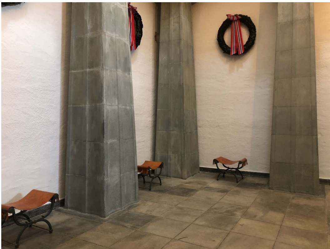
Figur 20: Hallens søyler i betong. Eget foto
