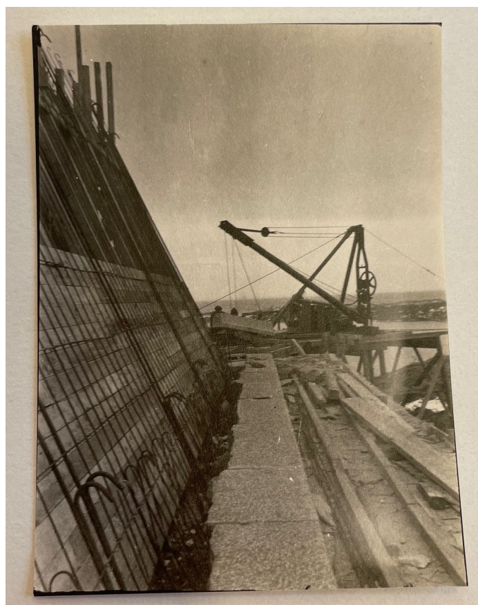
Figur 12: Armering av Minnehallen. Foto av Bjercke og Eliassen. Studiesalen, Nasjonalmuseet – Arkitektur. Ukjent årstall
