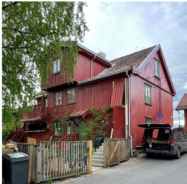
Figur 7: Bakgården i Normannsgata vitner om at tiltakene er iverksatt og pågår per 12. mai 2022. Det omtalte takvinduet vil bli plassert over verandaen som er til venstre i bildet. Sett fra Ullensakergata. Foto av forfatter.
