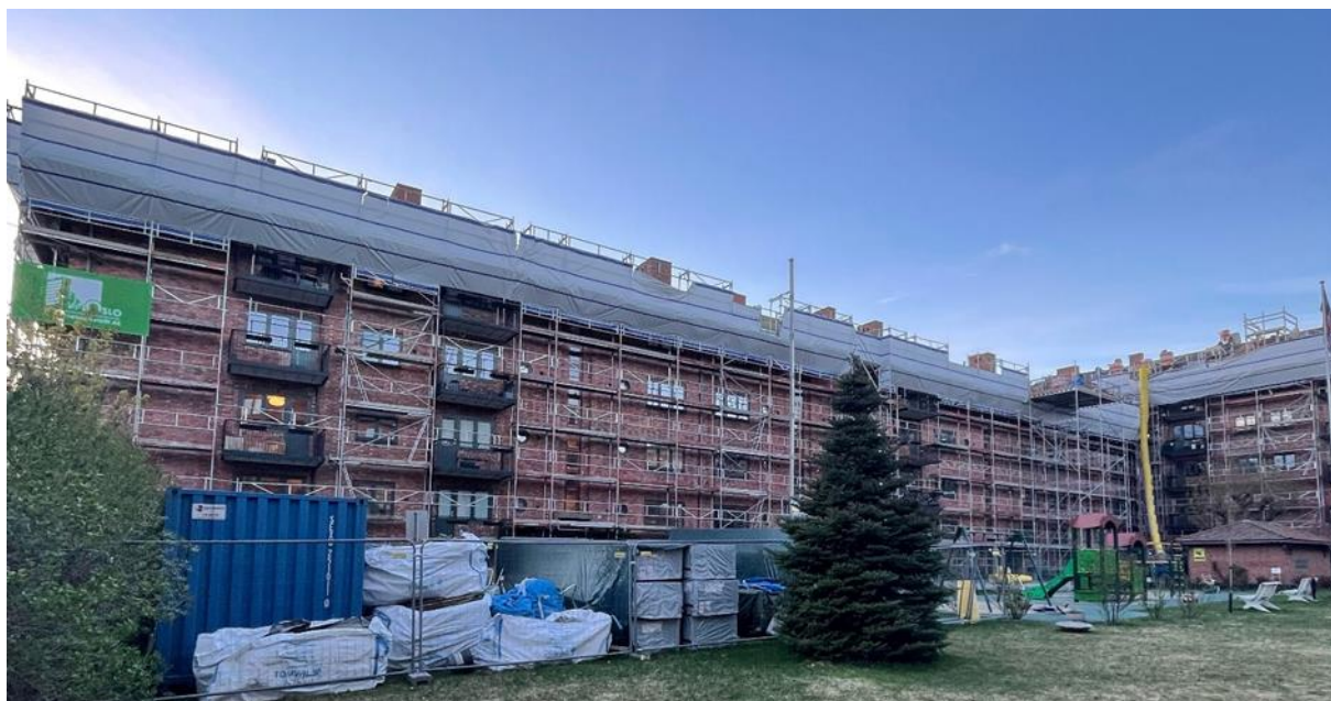
Figur 6: Tiltakene i Dælenenggata 11 er iverksatt og pågår per 03. mai 2022. PBE mener takvinduernes størrelse ikke negativt påvirker bygningens kulturelle verdi. Sett fra Dælenenggata. Foto av forfatter.
