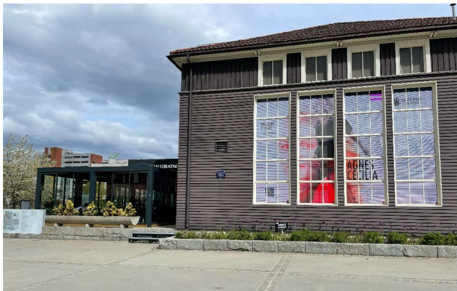
Figur 8: Den omtalte pergolakonstruksjonen er plassert til venstre for Kanonhallen. Sett fra Lørenveien 12. mai 2022. Foto av forfatter.
