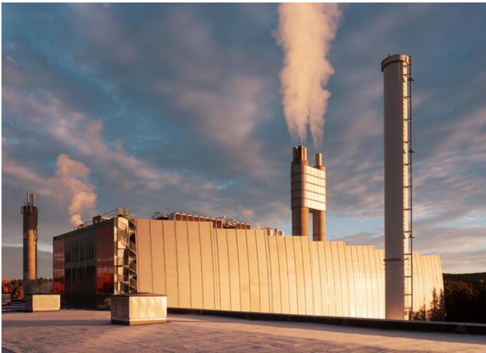
Figur 3: Fotografi av Fortum Oslo Varmes avfallsforbrenningsanlegg på Klemetsrud (Fortum 2022)
