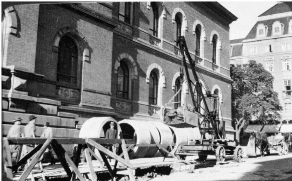
Figur 5: Bislettbekken utenfor Nasjonalgalleriet i Universitetsgata 13 fikk nye rørledninger på begynnelsen av 1930-tallet. ( Oslo byarkiv, Vann- og avløpsetaten , tilgjengelig under CC BY-SA 3.0 NO ). Uten tittel av ukjent (ca. 1932).
