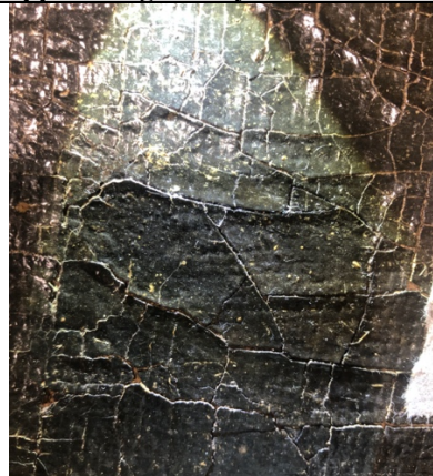
Figur 24 Detaljopptak etter utbedring av oppskalling i sidelys.
