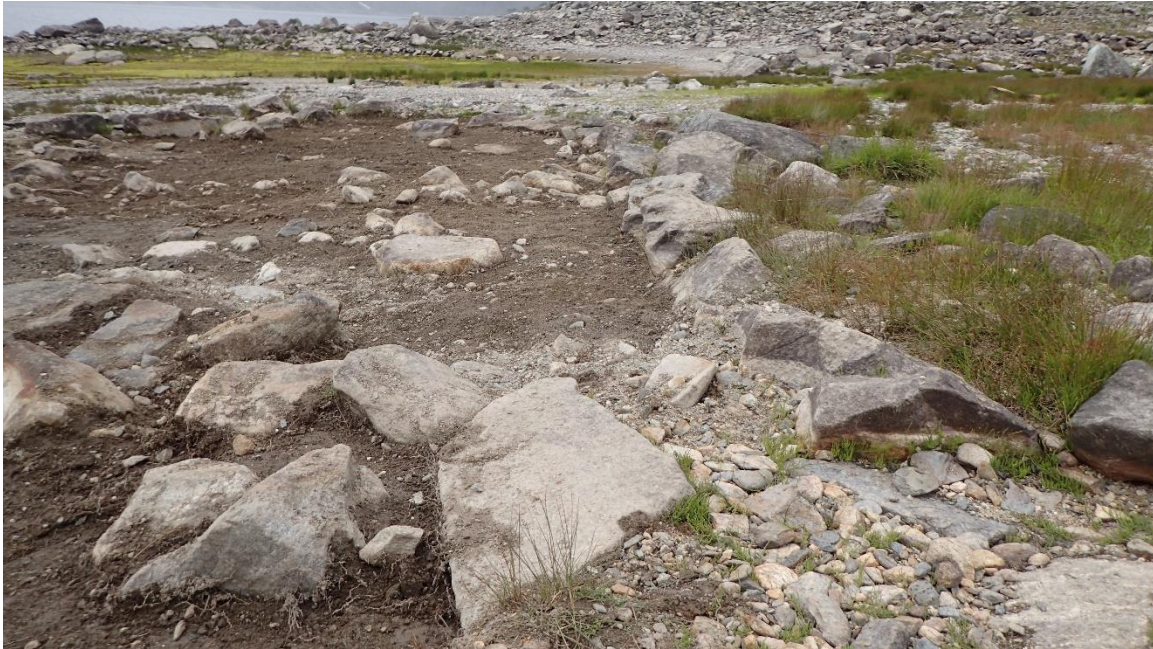
Figur 40 Nordveggen i tuft 1 fremstod som særlig rett langs innsiden i rom IV. I forgrunnen et mulig stolpefundament, i bakgrunnen er skilleveggen inn mot rom V synlig som en steinrekke på tvers av tufta. Cf35273_243, Foto: Lisbeth Skogstrand.
