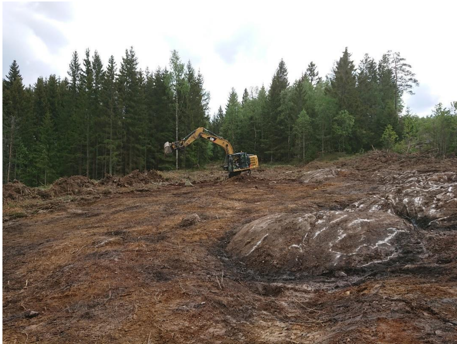
Figur 7: Arbeidsbilde, maskinell avtorving. Indre, vestlige halvdel av lokalitetsflata hadde langt mer kompakt, siltig undergrunn. Foto mot S. Fotograf: John A. M. Havstein.
