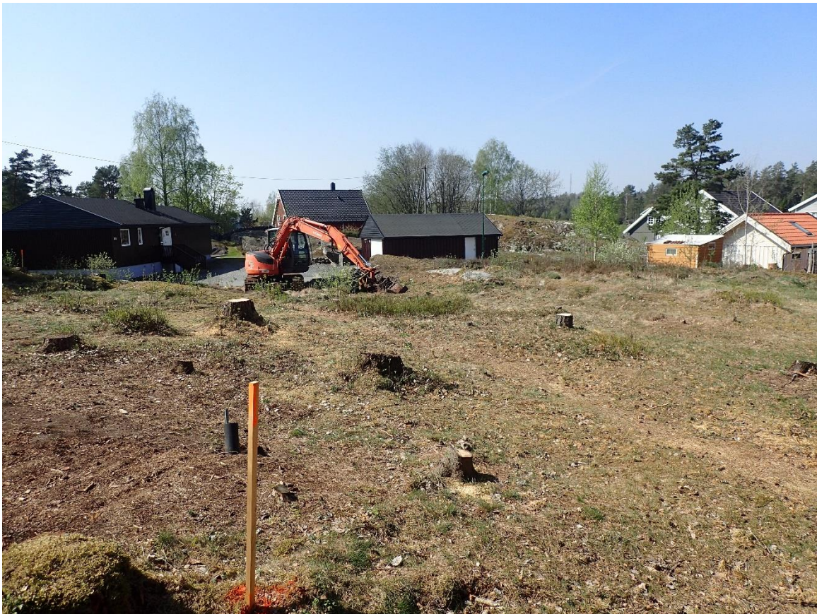
Figur 2: Lokaliteten før arbeidets oppstart, sett mot Ø. Den funnførende flata lå rett i forkant av gravemaskina, mellom to svaberg som så vidt kan skimtes under torvdekket. Fotograf: Fredrikke Danielsen, KHM.
