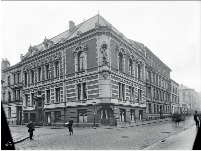
Figur 10: Det norske medicinske Selskabs gård Kristian IVs gate 9 fra 1893, her fotografert av Anders Beer Wilse (1865–1949) i 1907. På hjørnet var (og er) det et bevertningslokale. I en periode mens Selskabet holdt til i bygningen, var det restaurant Nürnberg Hof som var leietaker. Legg merke til at naboen, Hotel Bristol fra 1920 ennå ikke er kommet. (Oslo Museum)
