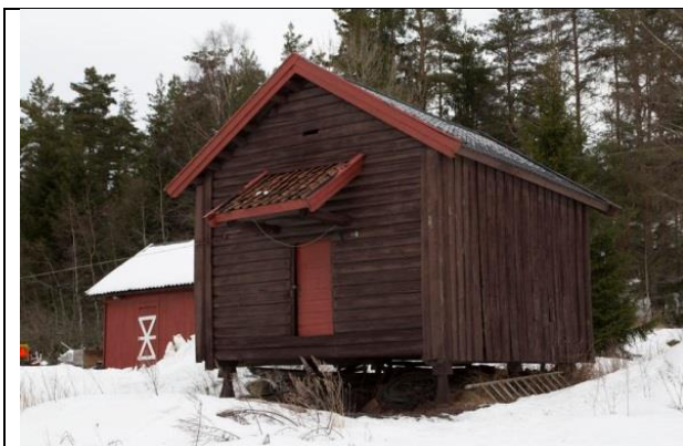
Bilete 9. Foto: Thore Bakk, Follo museum/MiA. Stabburet med panelveggen som dekkar lafteveggen.
