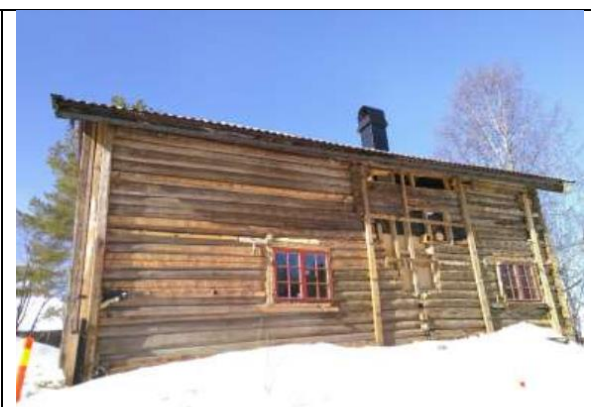
Bilete 12. Foto: Bygningsvernhuset. Svalgangsbygning etter demontering av panel. Tydeleg skadeomfang.
