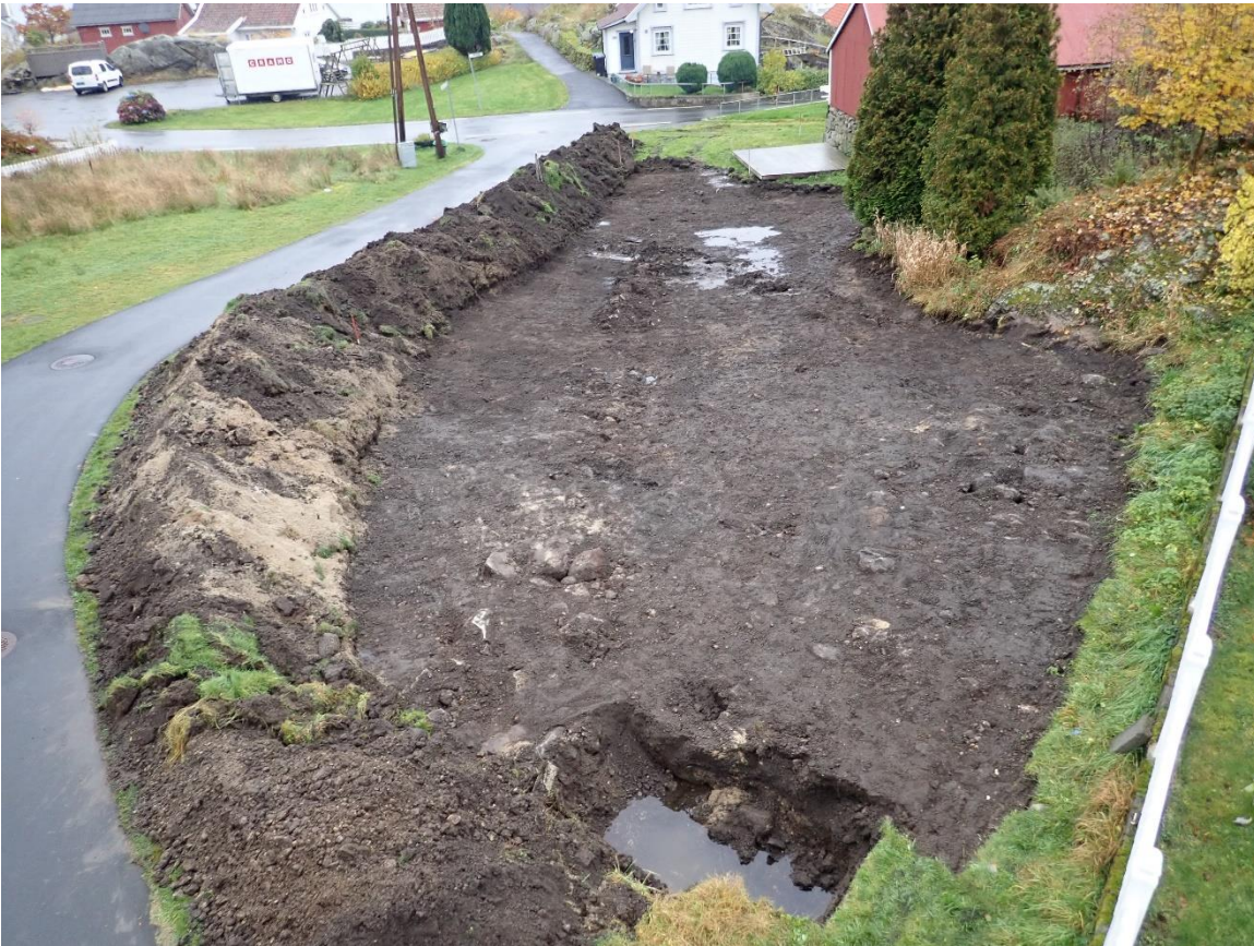
Figur 6. Andabeløy lok. 2 umiddelbart etter fjerning av de øverste fem centimeter av matjorden. Grøften nærmest i bildet ble gravd for å få et inntrykk av stratigrafiske forhold og for senere å ta av for soldemasser.
