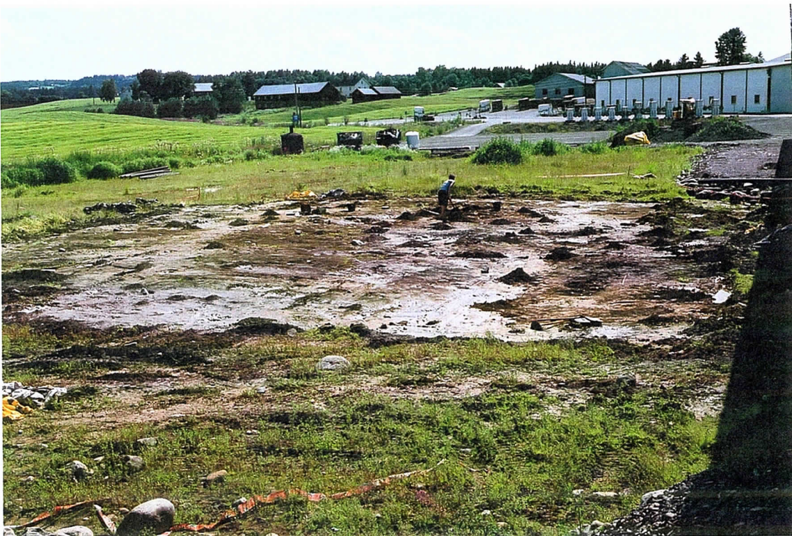
2. Oversiktsbilde. Retning: SSØ
