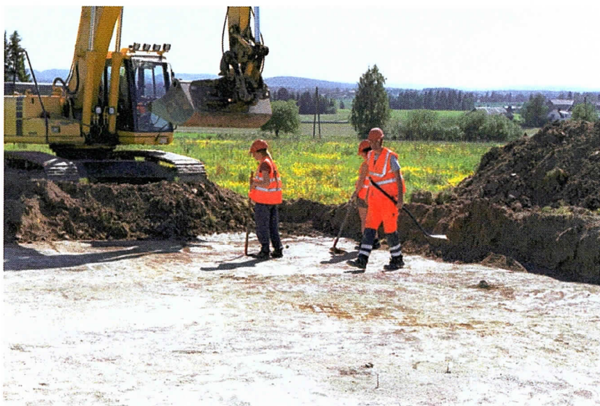
Fig 5. Arbeidsbilde med maskin.
