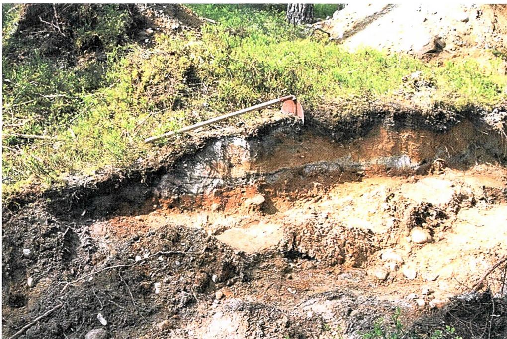
Figur 3. R9, terrassekanten mot S
