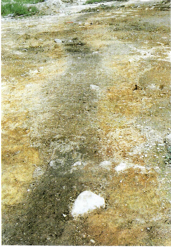
2/7 Hulveg overdækket under åker. Mot NNV
