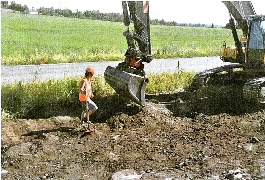
Flateavdekking med maskin i sjakt B, ved S7.
