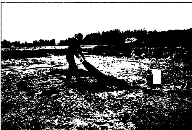
Bilde 2: Steg 2. Tildekk det fuktete området med filt.
