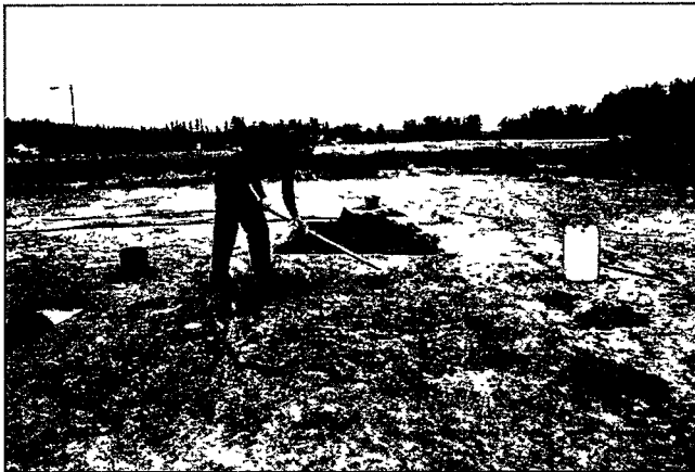
Bilde 5: Steg 5. Rens opp med krafse, etter at filten er fjernet.
