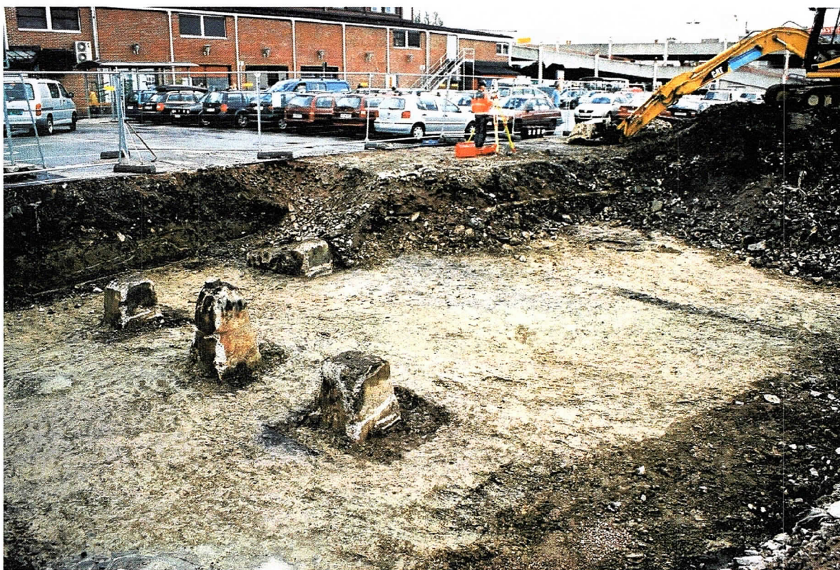
Figur 2 Betongstolper fra Foss jernstøperi. I profilet ved totalstasjonen sees også et betongfundament, trolig gulvet til bygningen.
