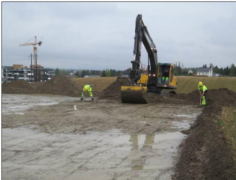
Figur 3: Arbeidsbilde av gravemaskin som flateavdekker og Synnøve og Aleksi som krafser (Cf35205_15).
