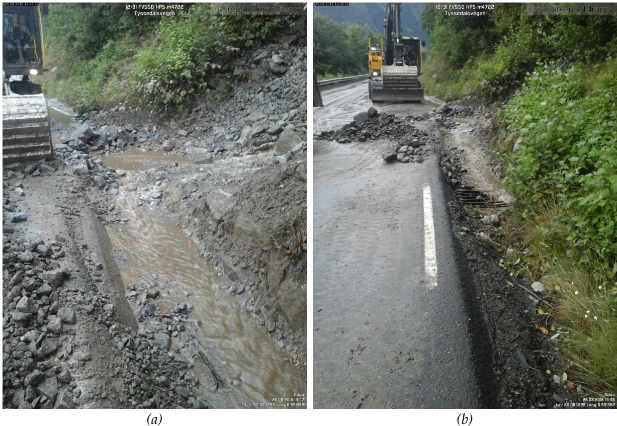
Figur 5.12: a: Bilde av skredutløp nær Byrkjenes. b: Bilde av skredutløpet i Byrkjenes. I veibanen ligger en blanding av steiner, grus, sand og leire. Begge foto fra RegObs (Elrapp).
