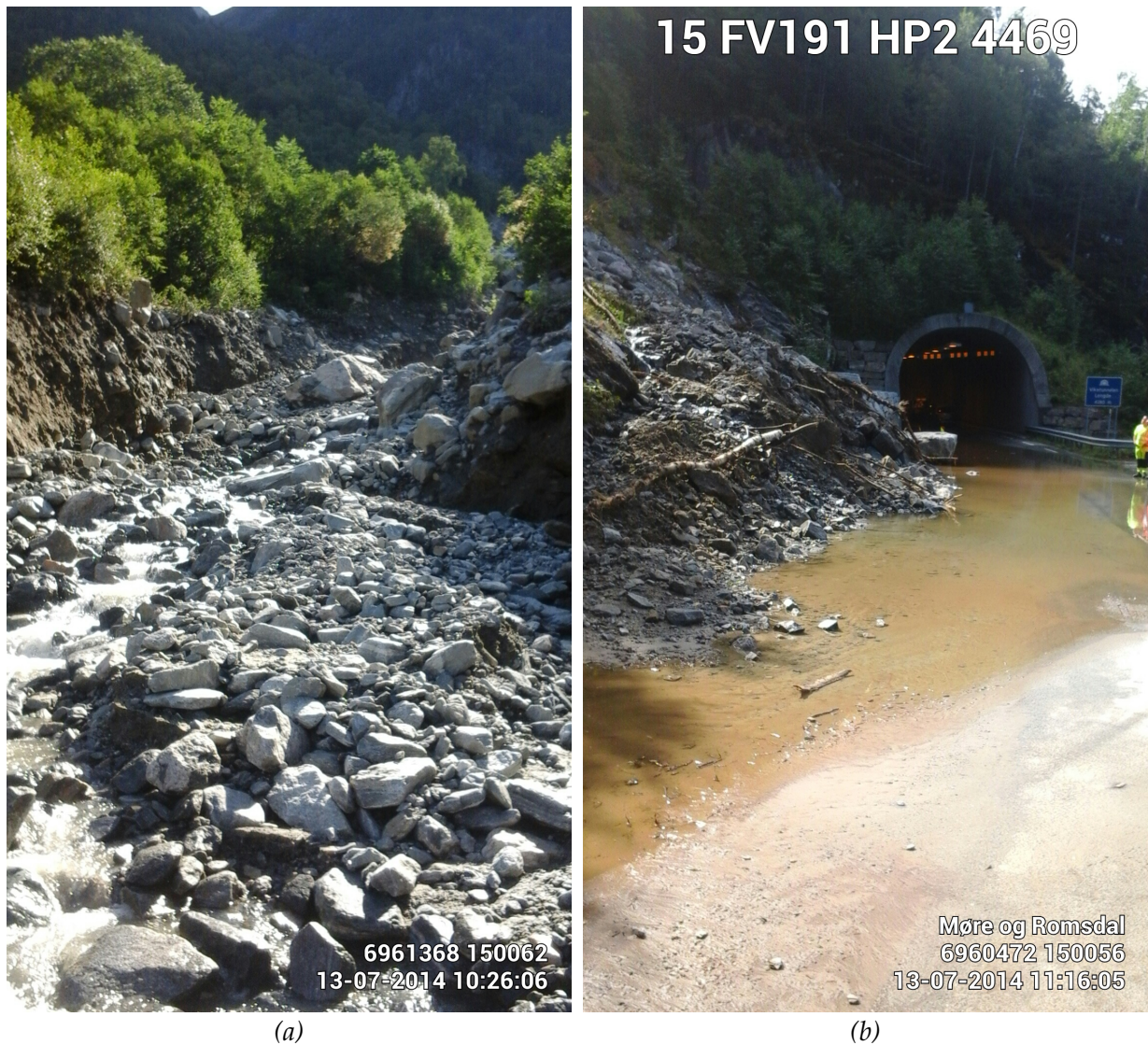
Figur 5.41: Foto tatt ved befarings av skredhendelsene langs Eikesdalen ved Eresfjorden. a viser skred 1 og b skred 2. Foto fra NVE.
