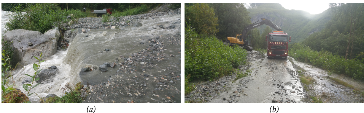
Figur 5.3: Foto tatt like etter skredhendelsen i Bøskrea. Det er fremdeles mye vann tilstede. Foto fra RegObs Bjørn Indrebø.
