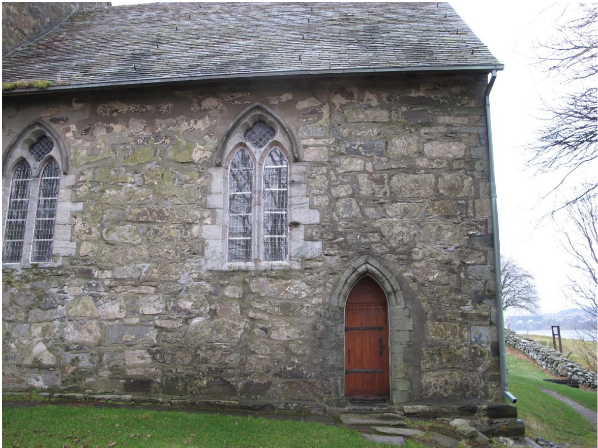
Figur 8.5.3o: Søndre korvegg i Olavskirken, med portal som slår utover. Sett mot N. Foto: Egil Marstein Bauer, KHM.
