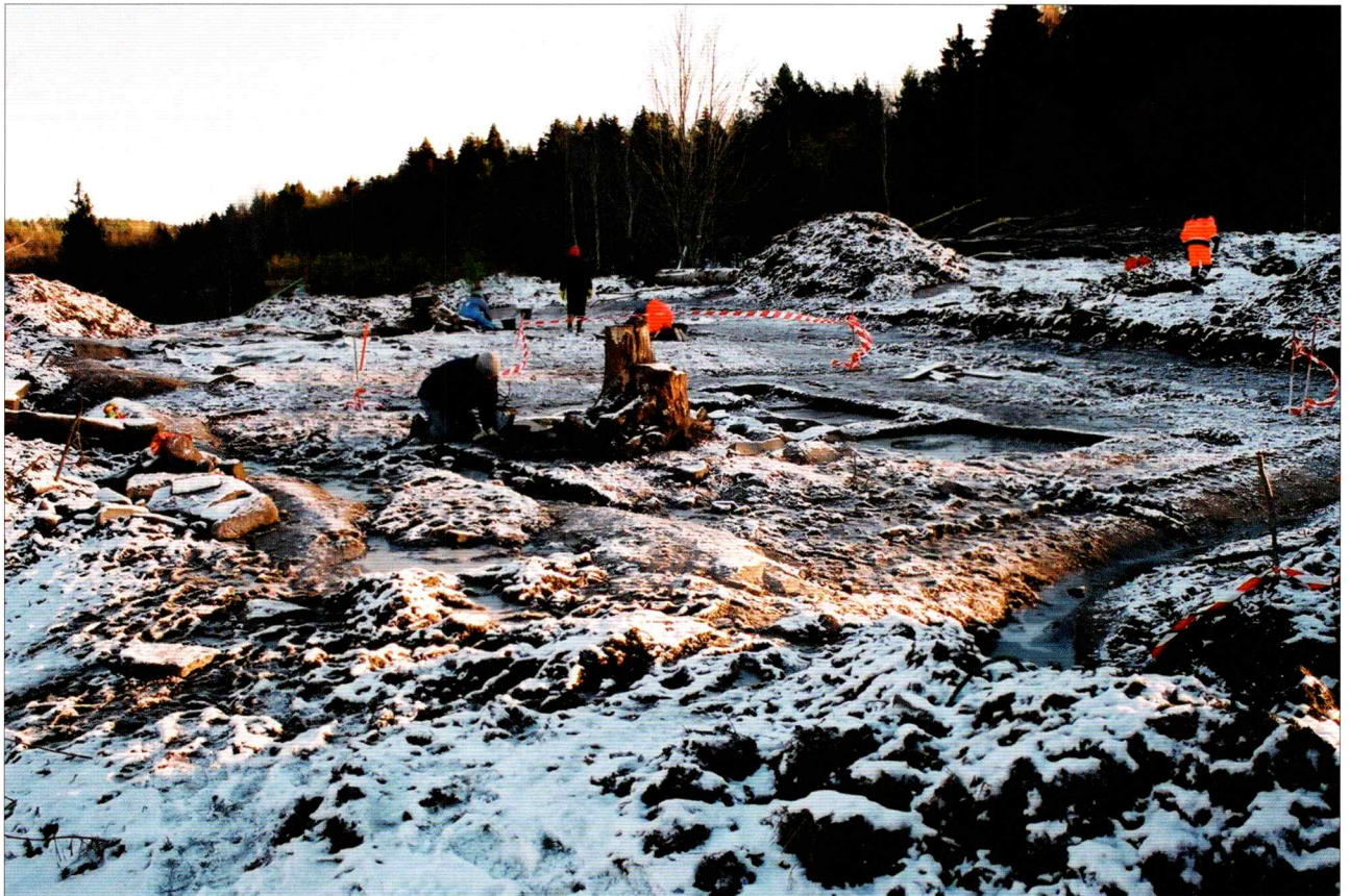
Figur 5.3. Utgravningsfeltet på Labo i Vestby kommune i Akershus (katalognr.13). Snø og kuldegrader skapte krevende utgravningsforhold. Foto: L. Jakslund, KHM.
