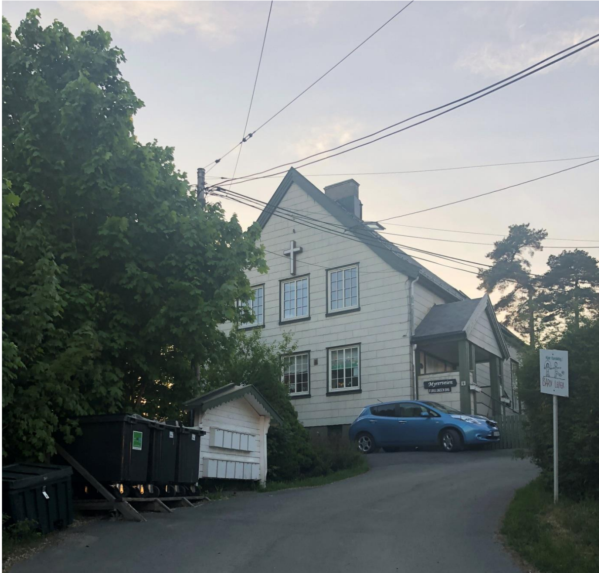
Kjelsås bedehus, Myrerveien 4. Foto: Marte Røbergshagen
