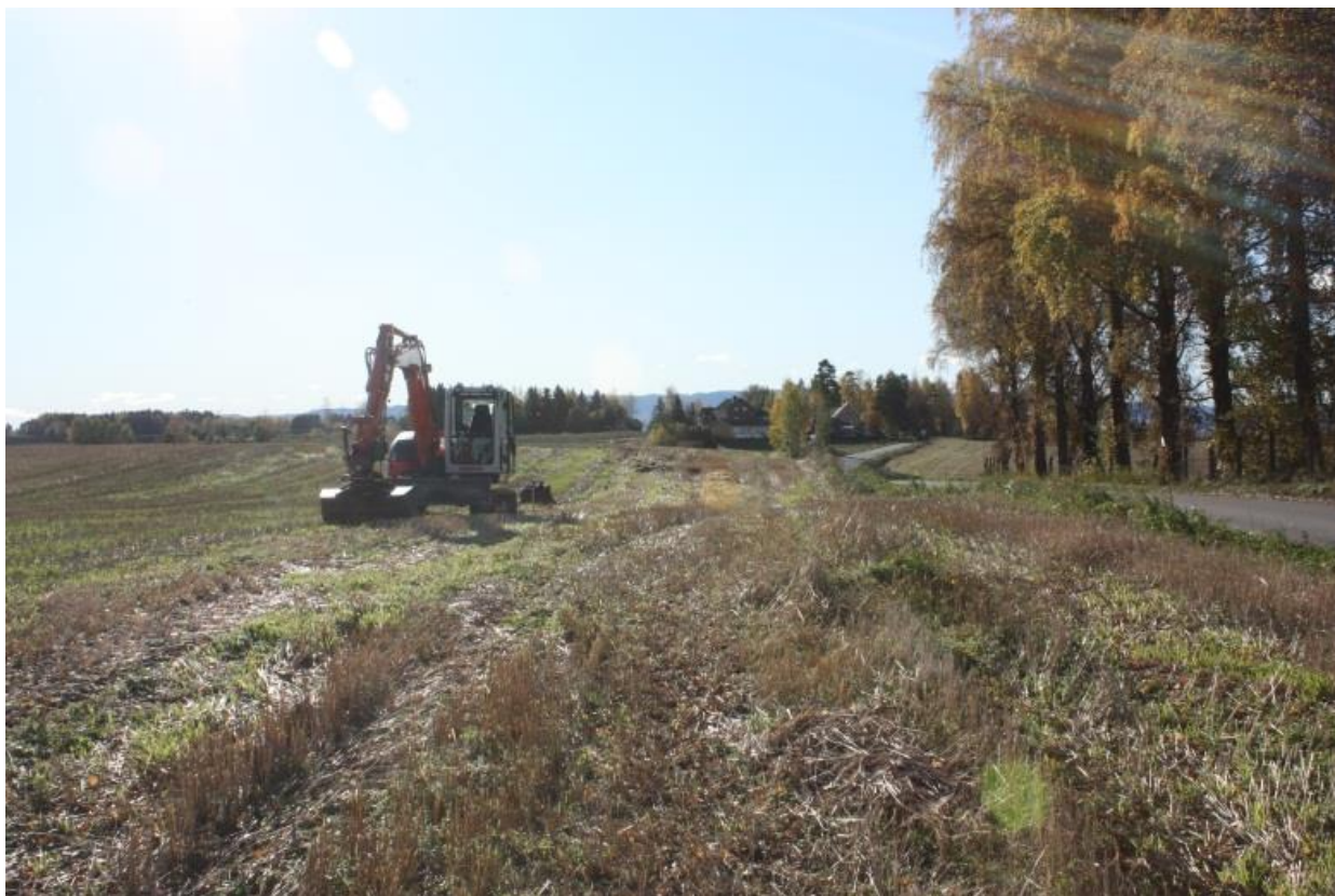
Figur 3: CF4515_002. Oversikt over planområdet før avdekking sett mot SSV. Foto: Anja N. Sætre
