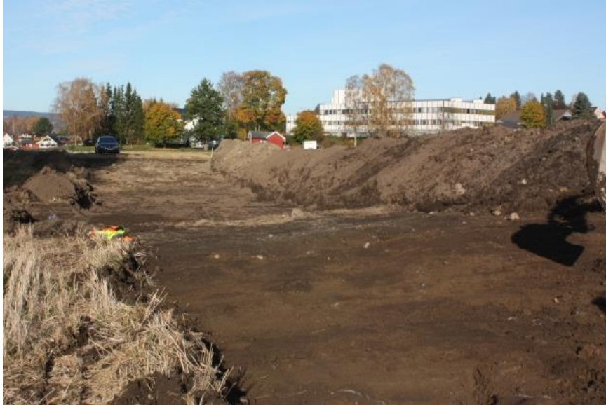
Figur 8: Cf4515_007 Oversiktsbilde sjakt mot NNØ. Foto: Anja N. Sætre
