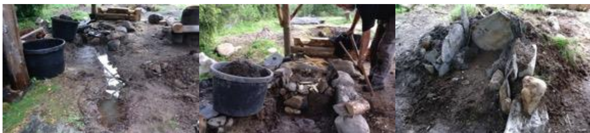
Fra venstre figur 11: Dreneringsgrøft ble laget ut fra ovnsstedet. Figur 12: Fundamentet ble laget av stein og grus i en tykkelse av 15-20 cm. Figur 13: Sjaktfoten laget av silt omgitt av stabiliserende heller på 3 sider.
