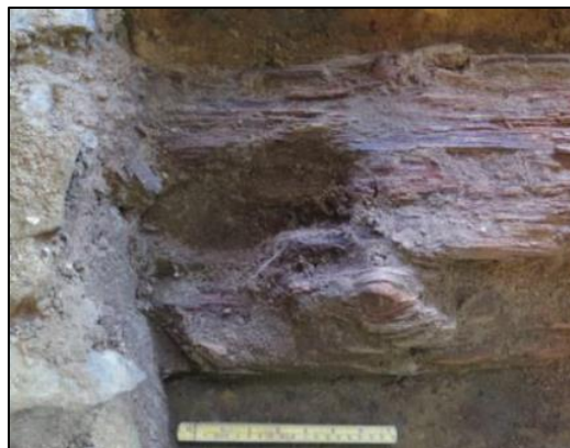
Figur 43: Innfellingshugg uten formål i stokk A25 som ligger inntil steinfundament til grue A4 (Cf35021_395).
