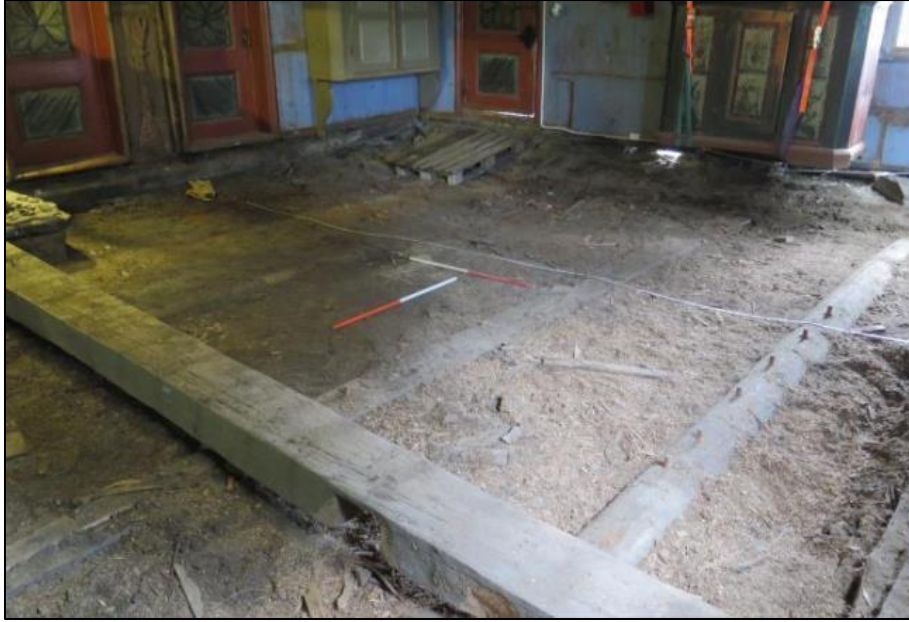
Figur 51: Flislag A37 samt gulvdragerne A41, A42 og A44 (Cf35042/142).
