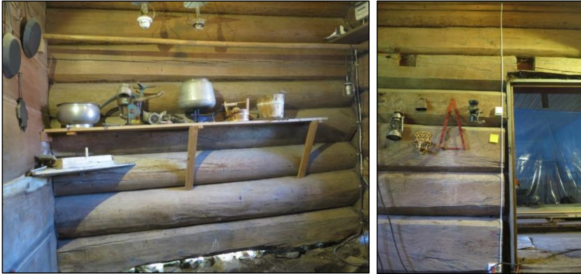
Figur 4 og 5: Foto til venstre viser laft i Forstua (Cf35021_1018). Foto til høyre viser innfellingskapp til taksperrer i laftestokk brukt i skilleveggen mellom Forstua og Storstua (Cf35021_1020).
