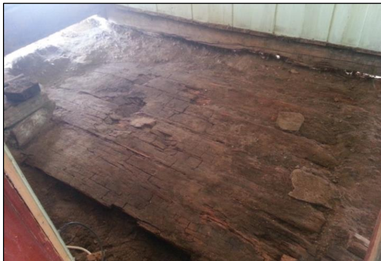
Figur 33: Plankegulv A5 da det først ble avdekket (Cf35021_1022).
