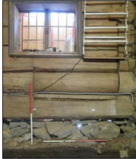
Figur 7: Gjenfylt, opprinnelig inngangsparti i forstua (Cf35021_1011).
