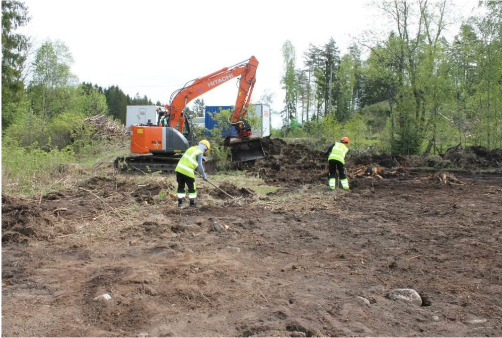
Figur 5: Avtorving av lok. 4 (Cf34794_842).
