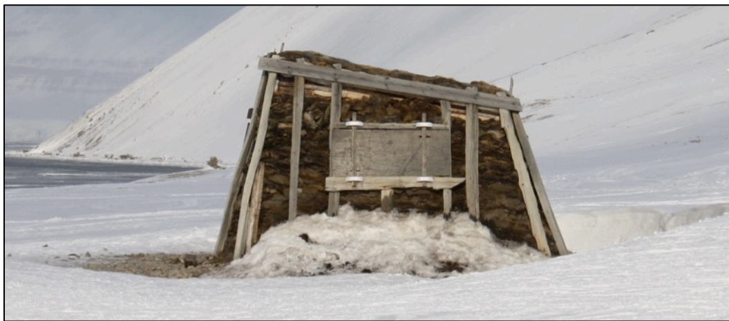
Bilde 7: Hytte 56- Gammelhytta , bilde tatt våren 2016. Hytten har gjennomgått restaurering , flytting og vedlikehold i moderne tid, men er opprinnelig oppbygget av blant annet av materiale fra andre nærliggende fangsthytter. Foto: Anders Bache
