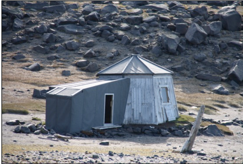
Bilde 5: Eksempel på lemhus, med tilbygg med pulttak (25:Kapp Lee).
