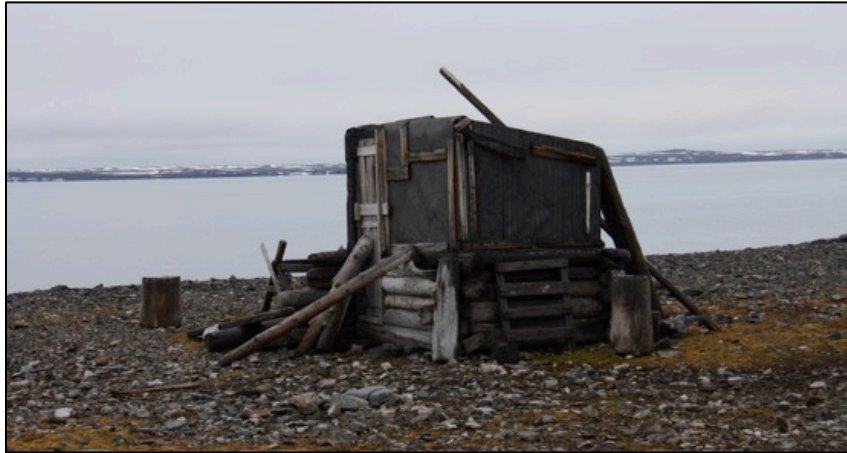
Bilde 2: Eksempel på hytte bygget med reisverk og laftet drivved, med pulttak. (153:Gråhuken II).
