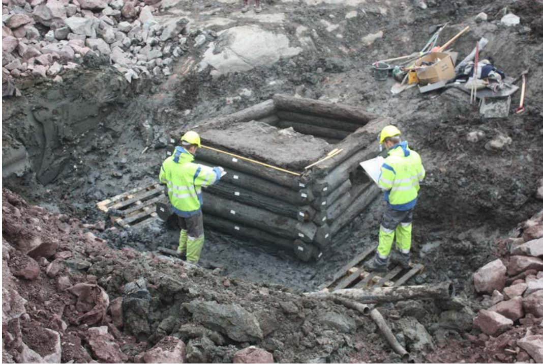
Cf34498_163. Registrering av konstruksjonen.
