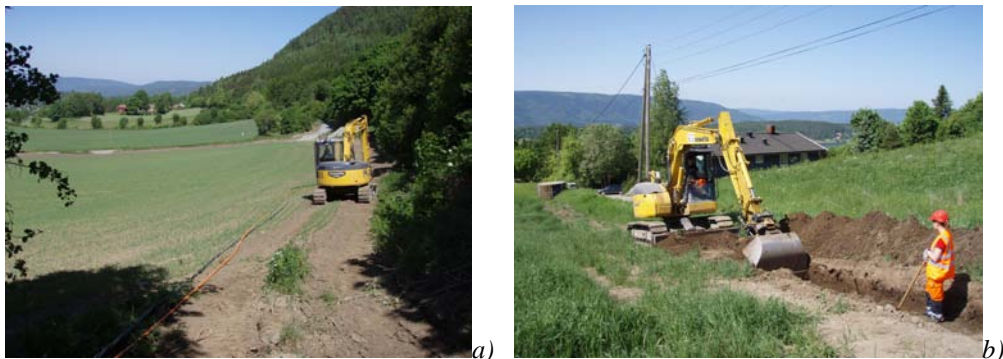
Figur 1a+ b: Avdekking med maskin. a) Lok. 1, med utsikt nord og vestover (Cf33977_1, tatt mot N). b) Lok. 2, sett mot nordvest. Feltassistent Benedikte Aaen overvåker arbeidet (Cf33977_3, tatt mot NNV; begge foto tatt av Camilla C. Wenn).
