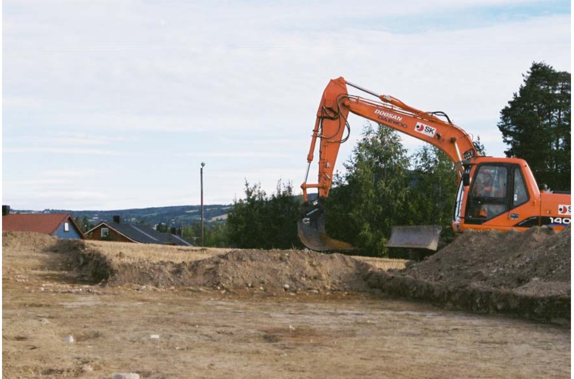
Fig. 3. Maskinell flateavdekking. Sett mot N.
