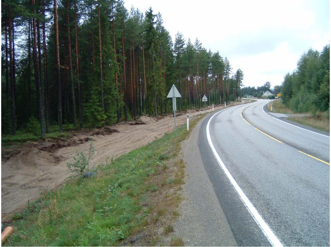
Den oppgravde traseen sett mot vest.
