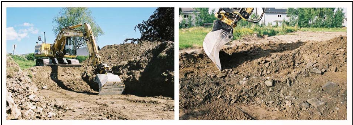
Bilde 2 Sjakting i påfylte masser.
