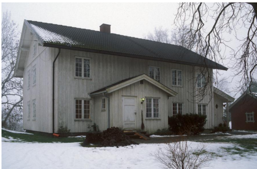
Figur 2: Foto av våningshuset med inngangspartiet til stua.
