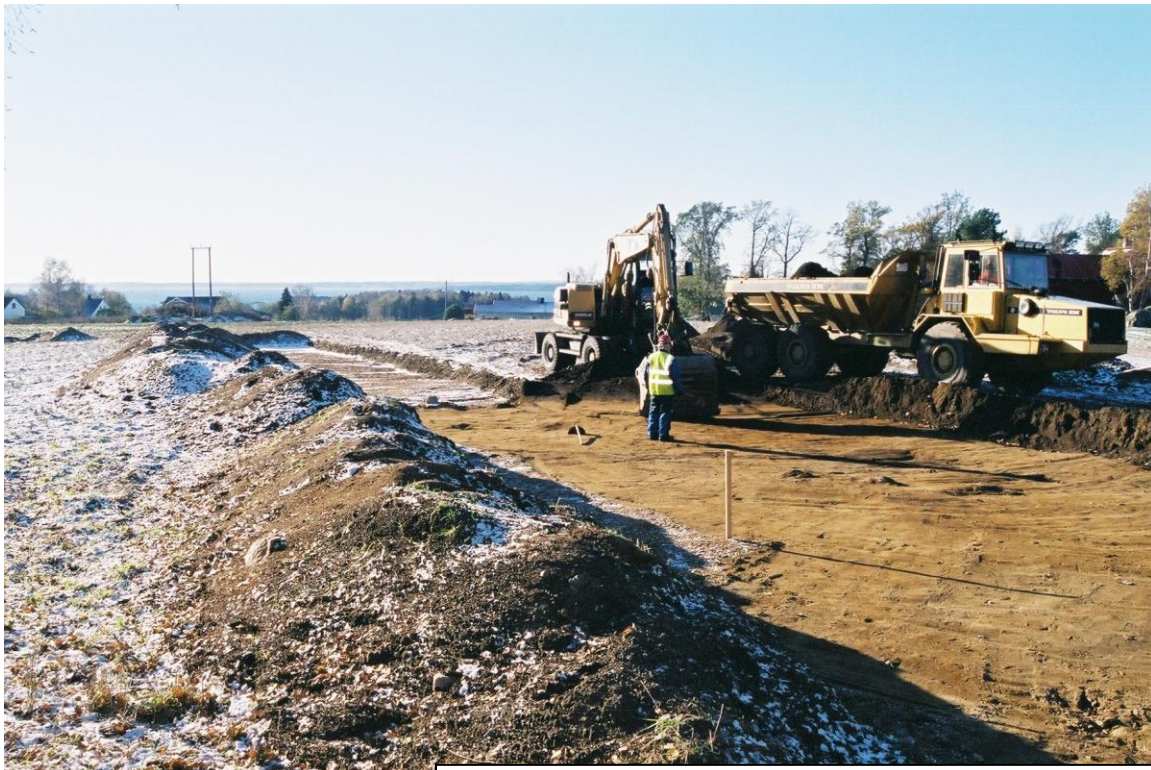
Maskinell flateavdekking med dumper nord på feltet, sett mot vest. Den åpne sjakten etter den fylkeskommunale registreringen ses bak t.v.
