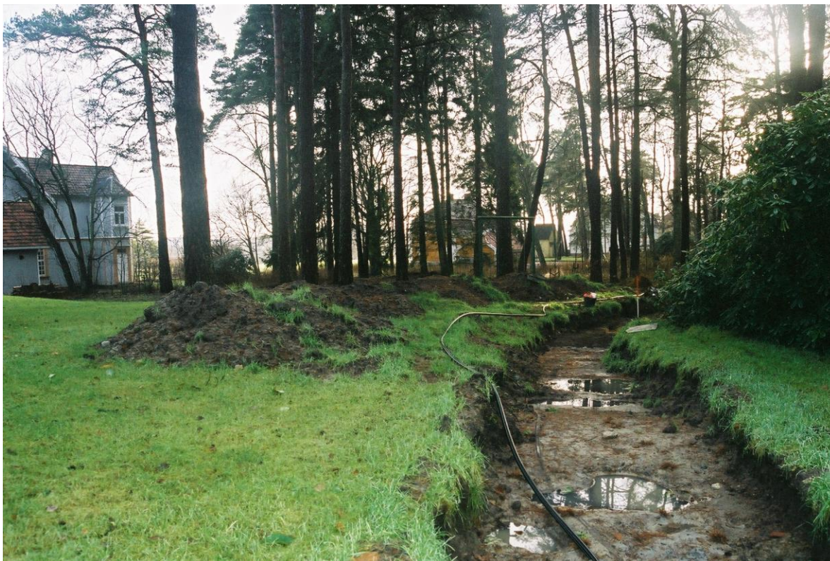
Oversikt over planområdet og utgravingsjakt, sett mot sør.
