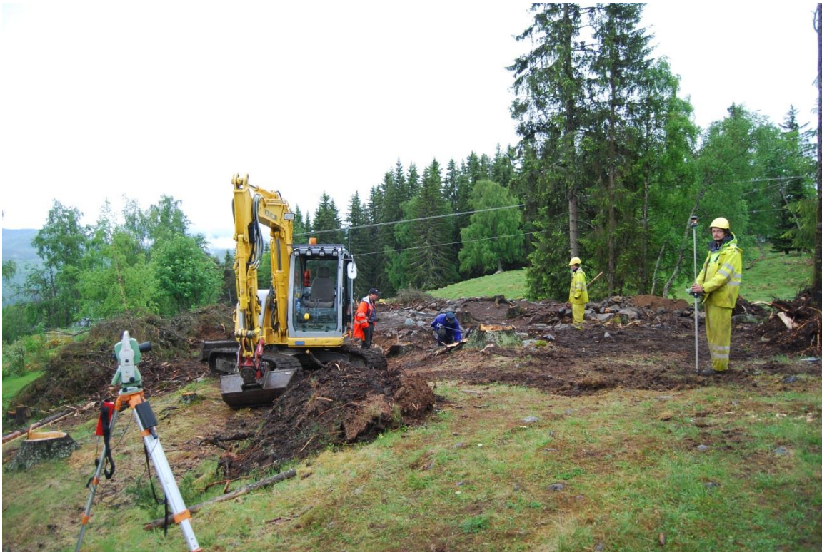
Figur 7. Cf34771-3-42 Under arbete, vecka 5. Sett mot S.
