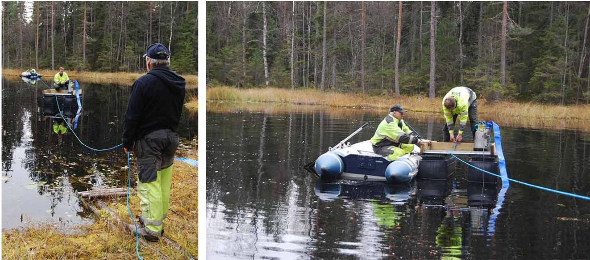
Figur 18: montering av vannpumpe i Elgsrudtjern (Cf:34760_34 og Cf34760_67). Foto C. Eymundsson 2013.
