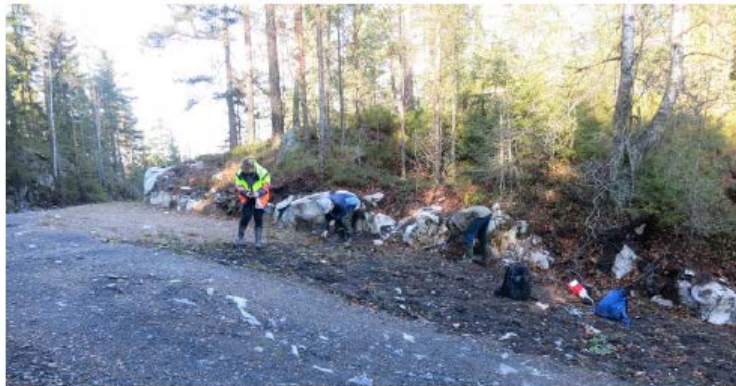
Fig. 3 Foto av skråningen hvor en skjellbanke hadde blitt gravd ut i forbindelse med en kabelgrøft til Follobanen. Skallene lå hovedsakelig i overflaten.
