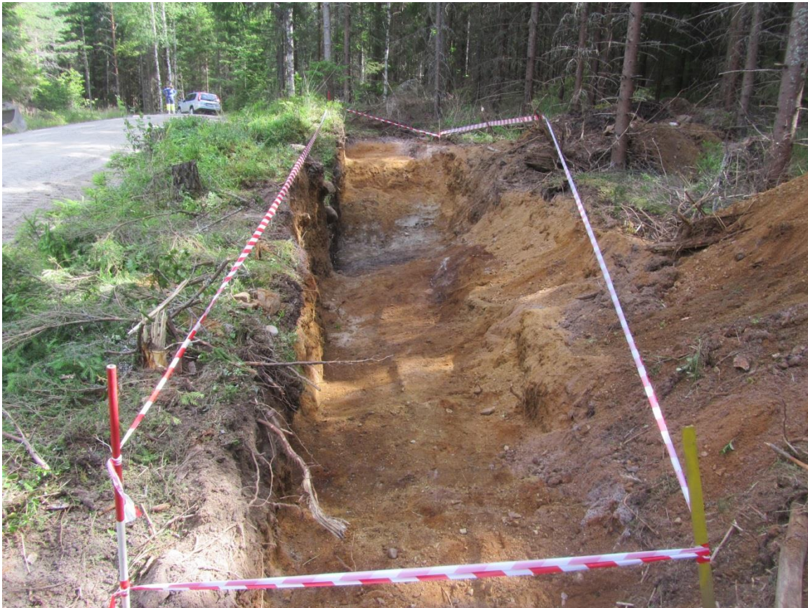
Figur 5: Sikring av sjakten før avreise 17.7. (Cf34732_33. tatt mot SØ).
