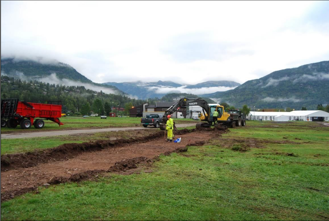
Figur 6. Cf34746_003.JPG. Avdekking påstartet. Hjullaster sees rett bak gravemaskin. Retning mot NNØ. Foto KHM.
