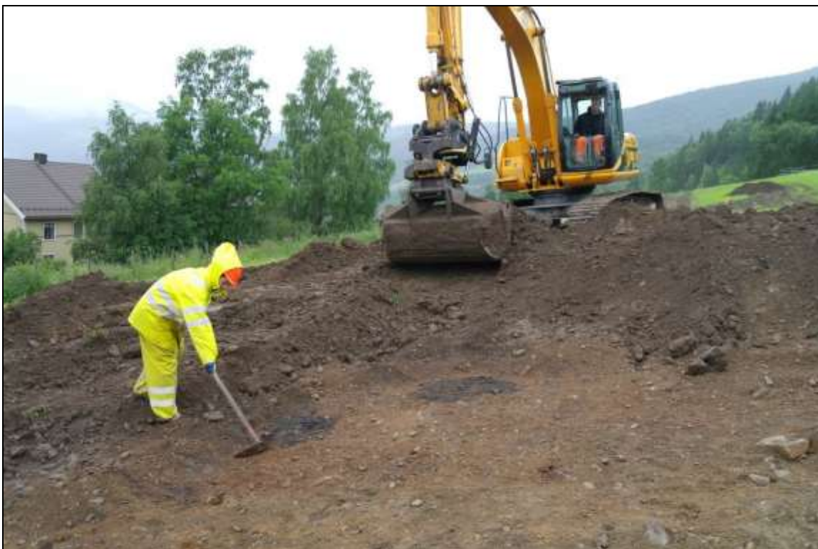
Cf34576_0010: HS avdekker i regnvær. Retning mot SSV. Foto: JKV.
