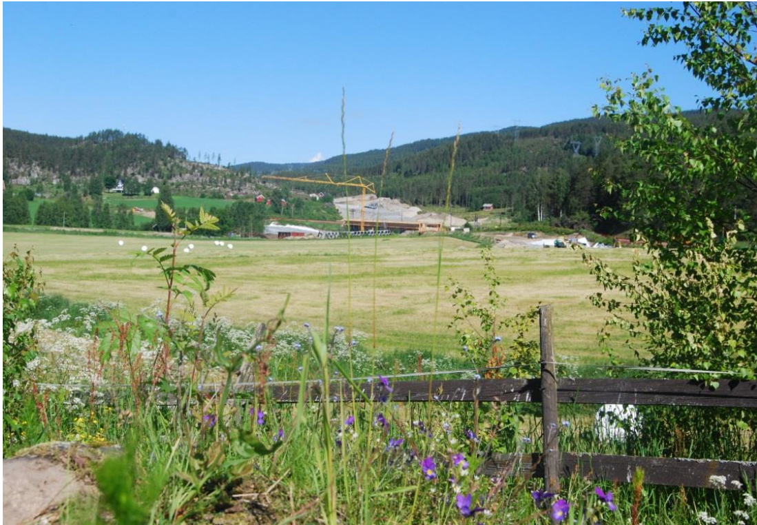
Utsikt over veitraséen mot NV sett fra røys S106. Anleggsarbeid med ny jernbanebro for Bergensbanen i bakgrunnen.
