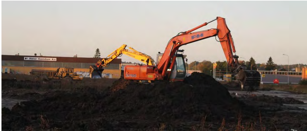
Figur 4: De to gravemaskinene flytter jord. Dumperen er etterlatt sør for undersøkelsesområdet.
