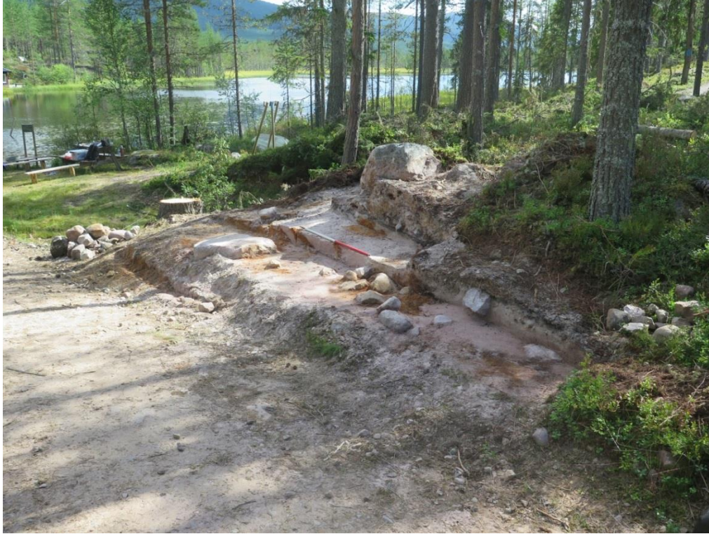
Figur 8 ID 174670 etter at erosjonssonen var jevnet ut. Partiet ble senket med 50 cm på det høyeste. Jordprofilene ble sikret med stein. Såliding av utgravde jordmasser foregikk ved Sagdammen, oppe til venstre i bildet. Foto: Cf35049_035. Retning: SØ. Fotograf: SVN.
