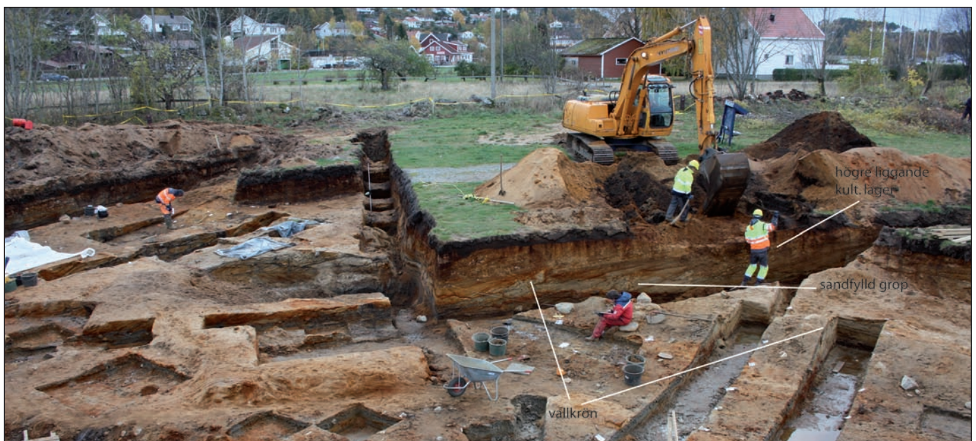
Figur 48. Arbetsbild schakt 11 under utgrävning. Lägga märke till nivån som det schaktas ned i profilen.
