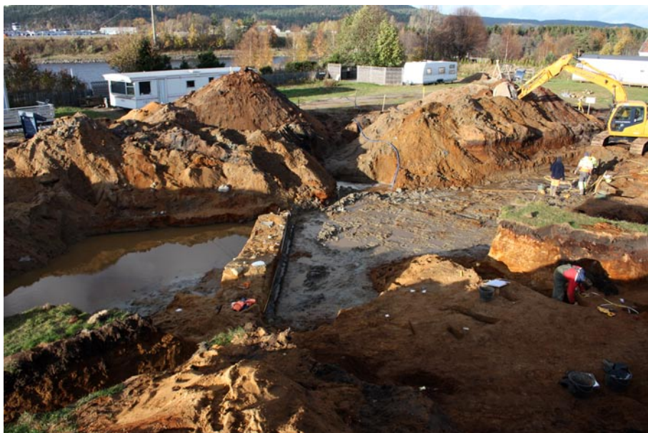
Figur 57. Arbetsbild som visar schakt12 efter att L5 blottlagts. Centralt i bilden ses profilbanken mellan de båda rutschakten 11B. Nere till höger i bilden syns schakt 11.
