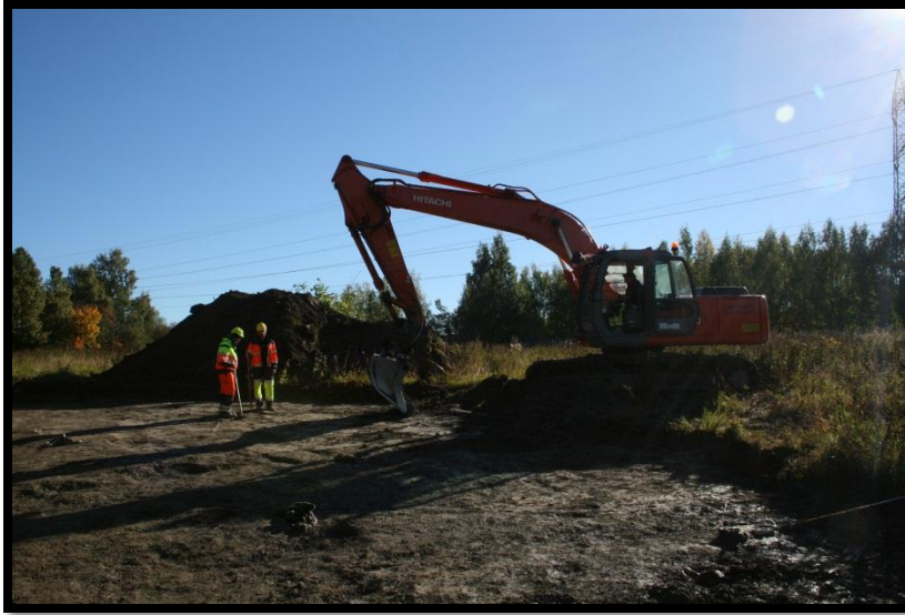
Figur 3: Arbeidsbilde med Lars Haugesten og Håvard Hegdal, Ingar Jogerud kjører gravemaskinen.
