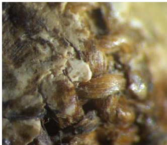
Fig. 29: Detaljopptak gjort i arbeidsmikroskop av nederste høyre hjørnet. Lerretsfibrene var synlig impregnert med det som trolig var proteinbasert lim. (30x).
