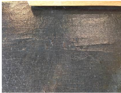
Figur 55: Antydninger til oppskallinger ved venstre kant (a), i horisontale krakeleringer (b) og større oppskallinger i øvre del av motivet (c).
