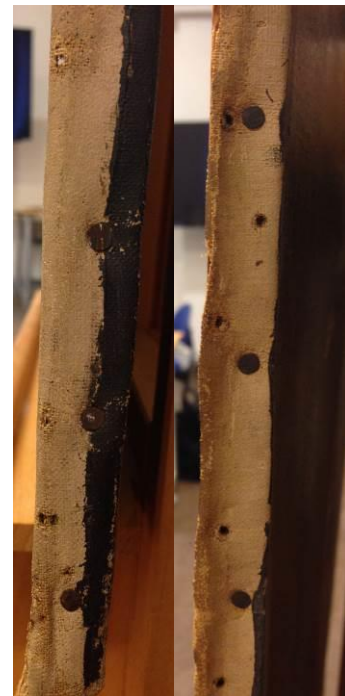
Figur 36: Spor etter tidligere oppspenninger i brettekanene
