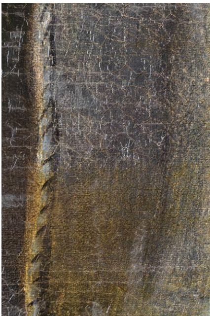
Figur 65: Underveis i rensing av kappen. Overflaten mettet med white spirit
